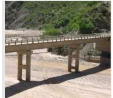
Brücke über den Rio Cachimayo
